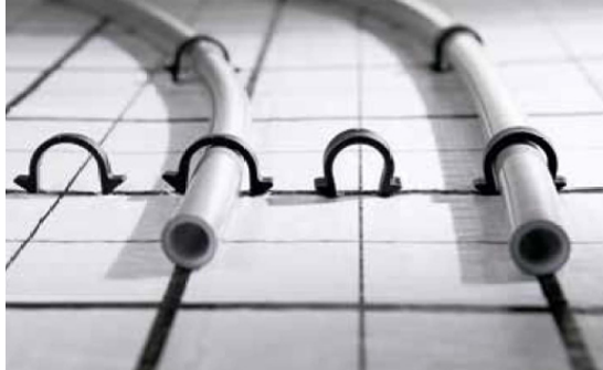
Fußbodenheizung Tackersystem, Hersteller TECE o. glw.
